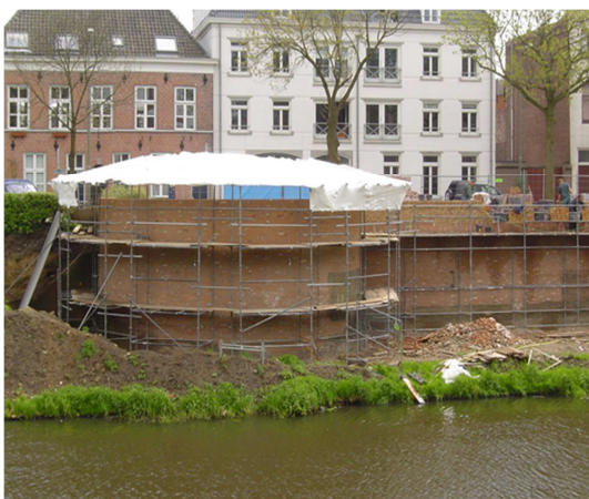
Restauratie rondeeltoren Westwal in 2006
