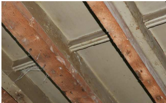
Detail van de balklaag met spreidsellatjes in Postelstraat 44
